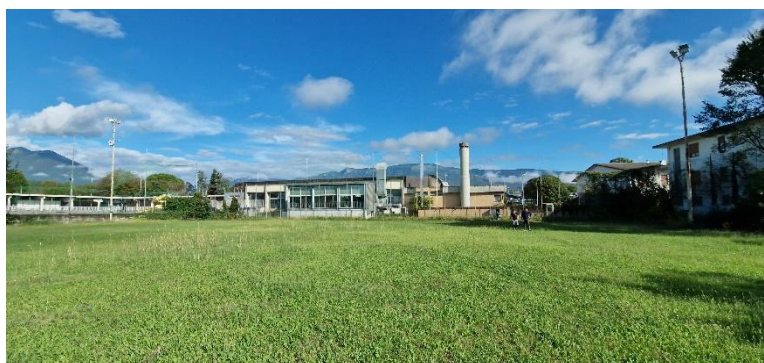
Edificio visto dal campo da calcio
